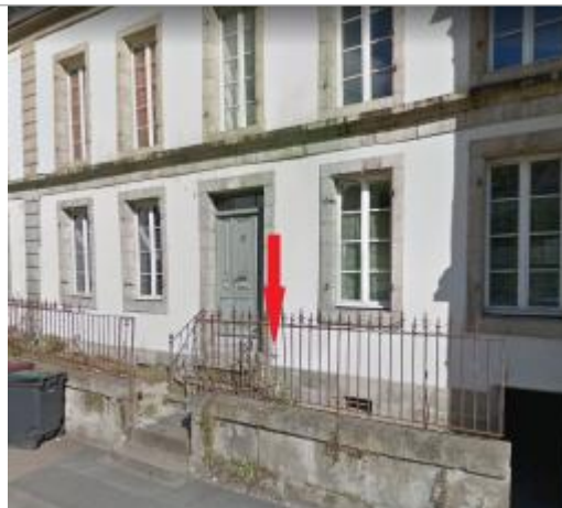
Vue d'ensemble de la façade du bâtiment d'habitation
