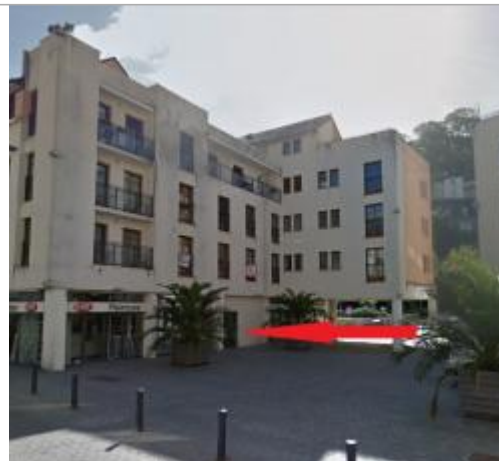
Vue d'ensemble de la façade du bâtiment
