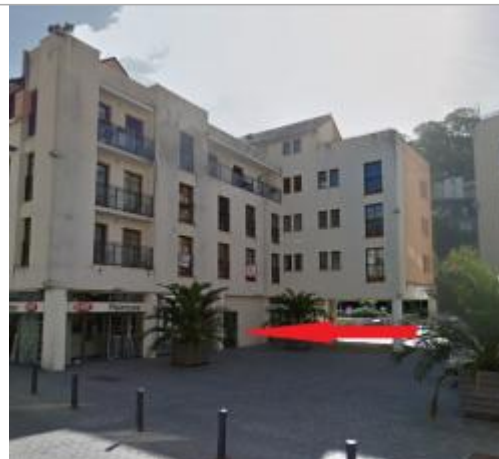
Vue d'ensemble de la façade du bâtiment
