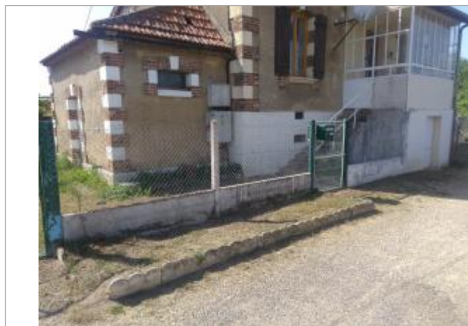
Localisation de l'escalier d'accès
