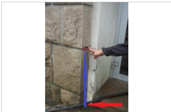
laisse de crue au niveau de l'angle du mur de la porte d'entrée
