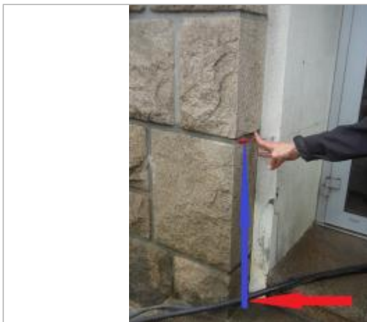
laisse de crue au niveau de l'angle du mur de la porte d'entrée
