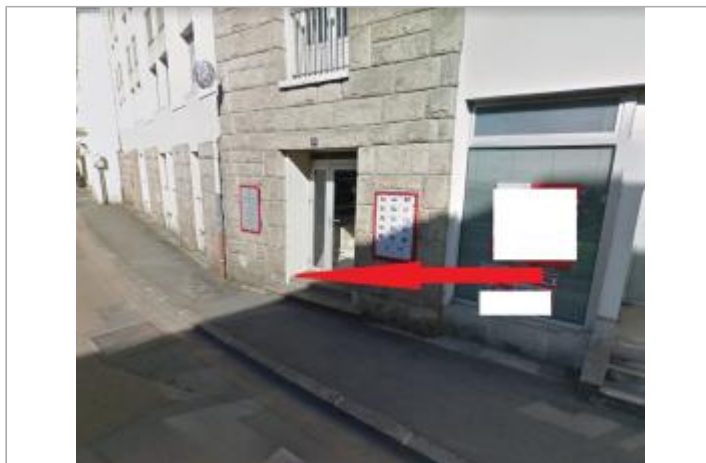
Vue d'ensemble de la façade du bâtiment
