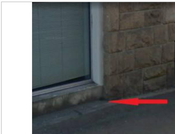
Trottoir au droit du côté droit de la baie vitré
