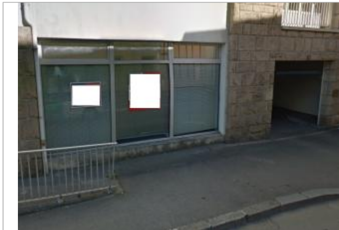
Façade du bâtiment
