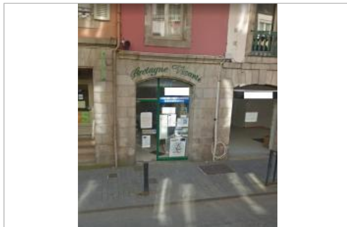
Façade du bâtiment
