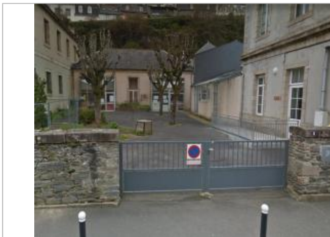
Vue d'ensemble de l'entrée de l'école
