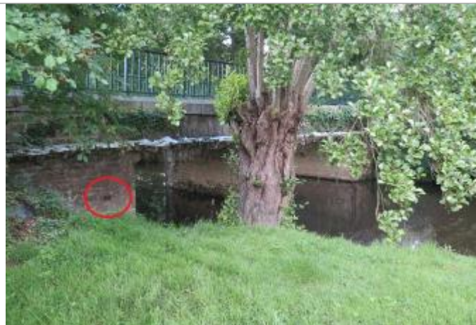
Vue d'ensemble du pont
