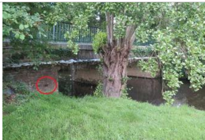
Vue d'ensemble du pont
