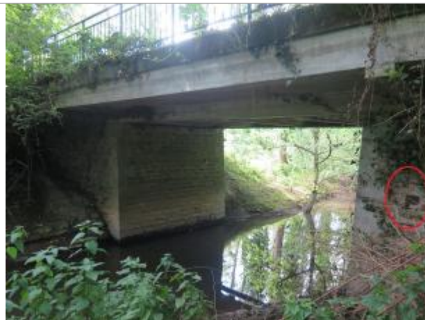
Vue d'ensemble du pont
