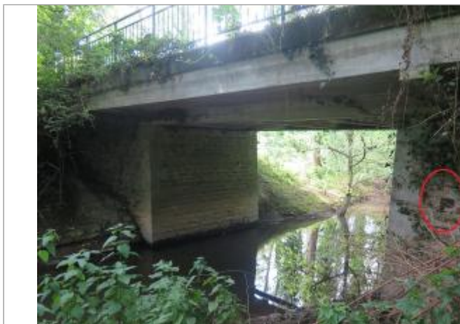
Vue d'ensemble du pont
