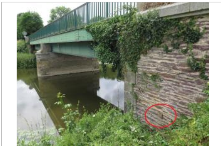
Vue d'ensemble du pont
