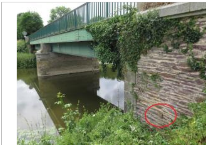
Vue d'ensemble du pont
