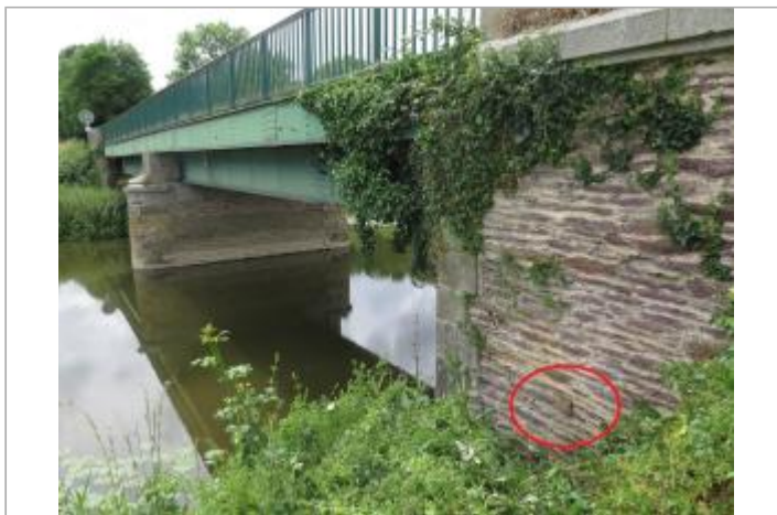
Vue d'ensemble du pont
