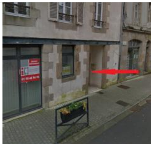
Vue d'ensemble de la façade du bâtiment
