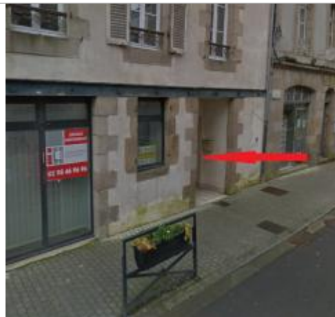
Vue d'ensemble de la façade du bâtiment
