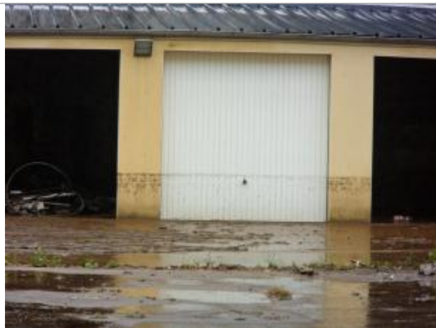
Cour intérieur du bâtiment
