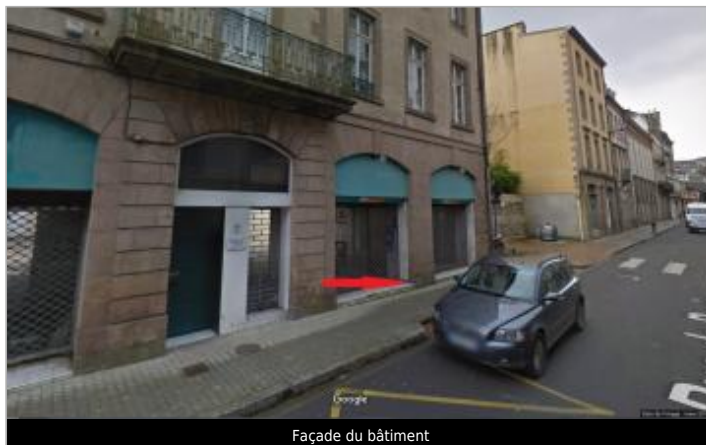
Façade du bâtiment
