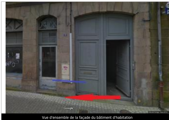
Vue d'ensemble de la façade du bâtiment d'habitation
