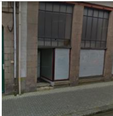
Vue d'ensemble de la façade du bâtiment
