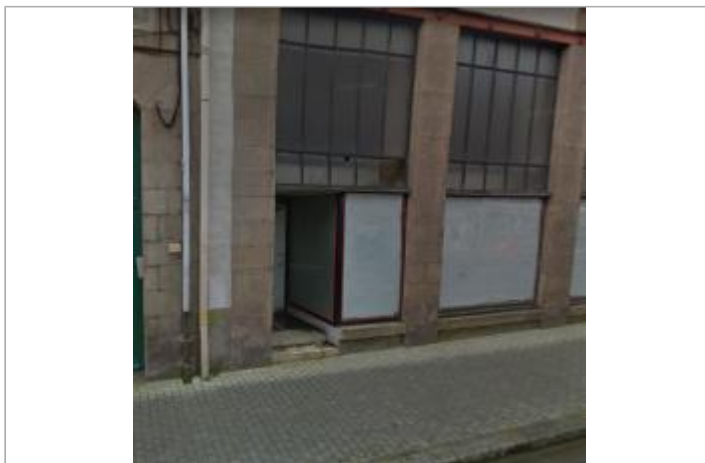
Vue d'ensemble de la façade du bâtiment
