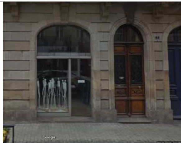
Vue d'ensemble de la façade du bâtiment
