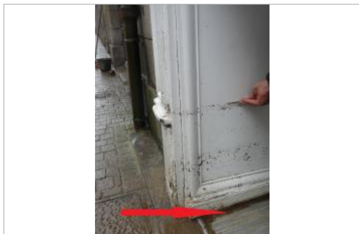
Seuil coté gauche du porche
