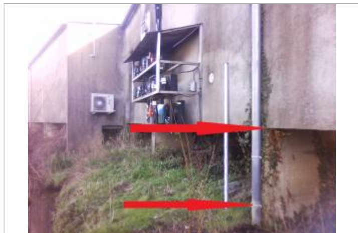
Dessous de la dalle béton du bâtiment servant de référence
