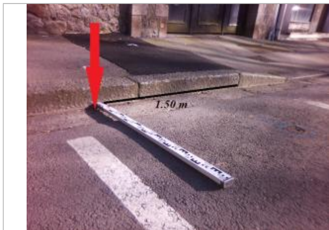
Sol voirie pied de trottoir
