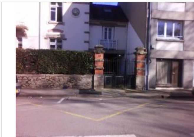
Facade du bâtiment d'habitation
