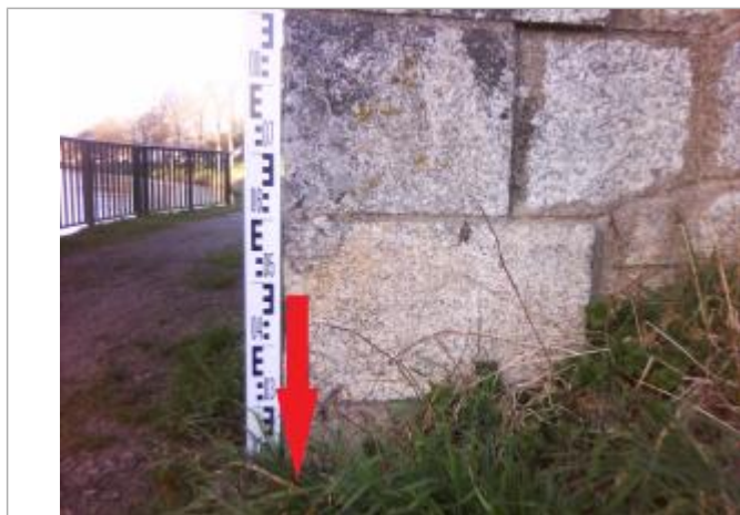
Sol : pied de la culée rive gauche - sous le pont Signan
