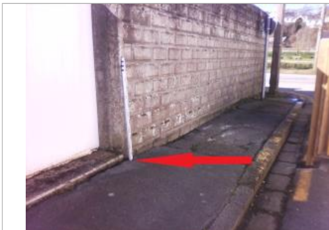
Sol côté droit du mur de l'entrée charretière
