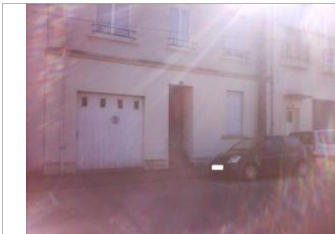
Facade du bâtiment d'habitation
