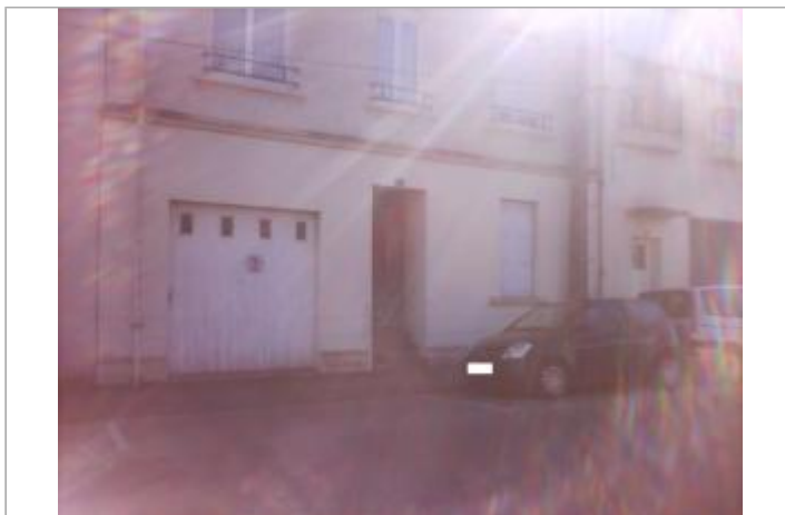
Facade du bâtiment d'habitation
