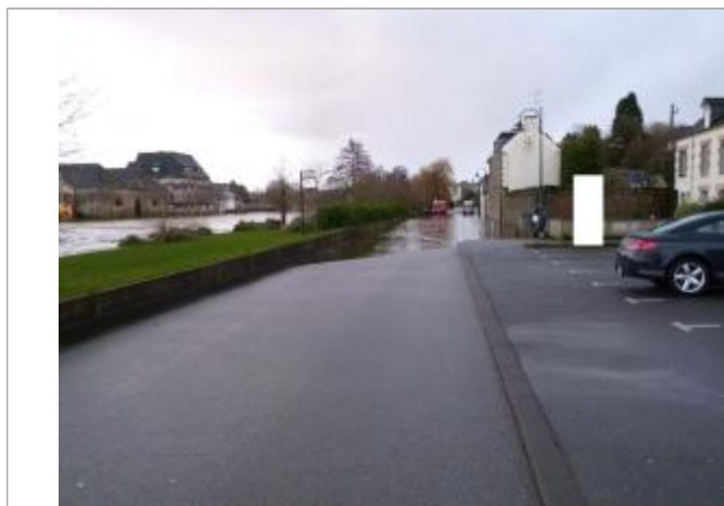
Vue d'ensemble du site lors de l'inondation
