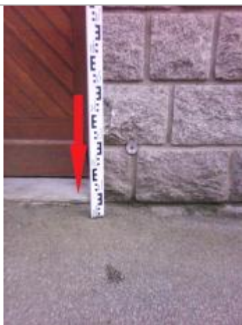
Seuil de la porte d'entrée de l'habitation
