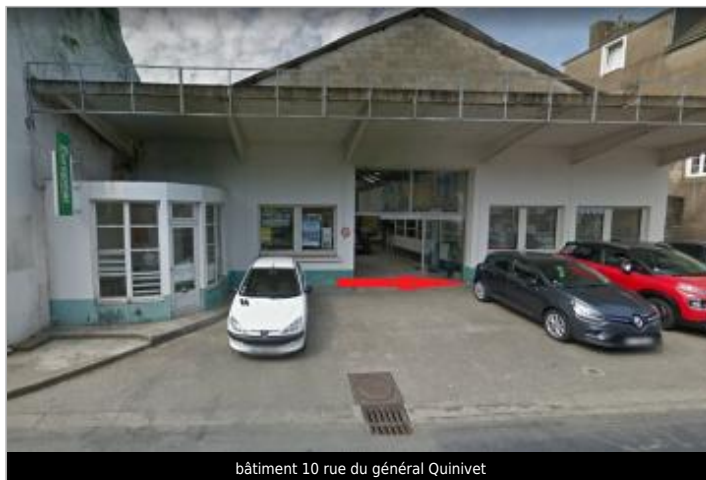
bâtiment 10 rue du général Quinivet
