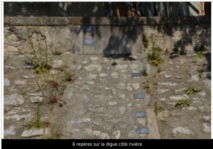
6 repères sur la digue côté rivière
