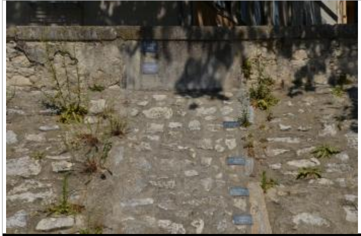
6 repères sur la digue côté rivière
