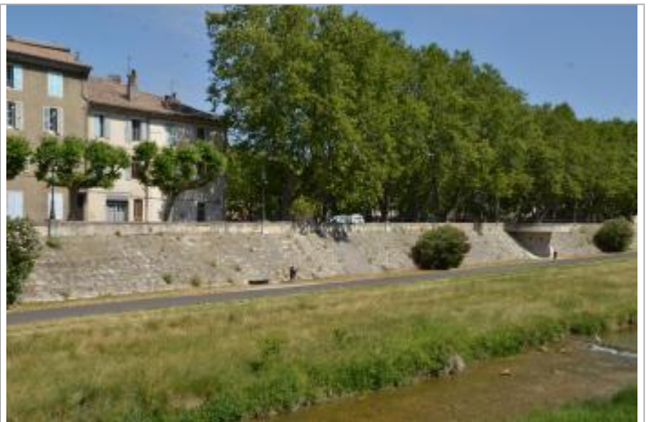
Vue générale du site, les repères sont sur le parement de la digue.
