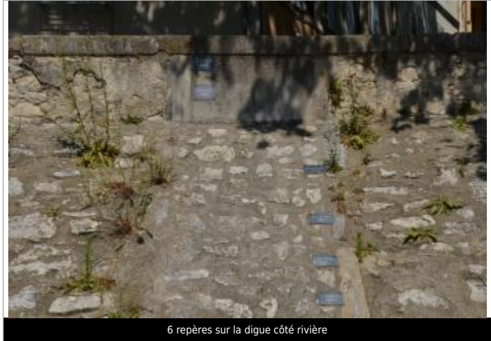
6 repères sur la digue côté rivière
