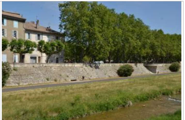
Vue générale du site, les repères sont sur le parement de la digue.
