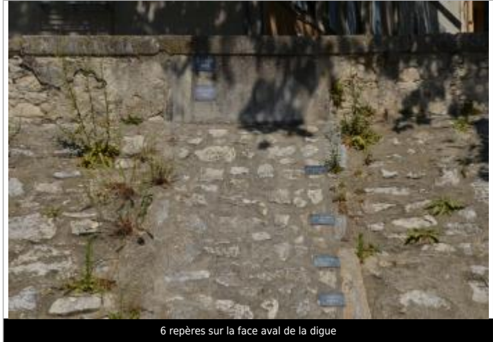
6 repères sur la face aval de la digue
