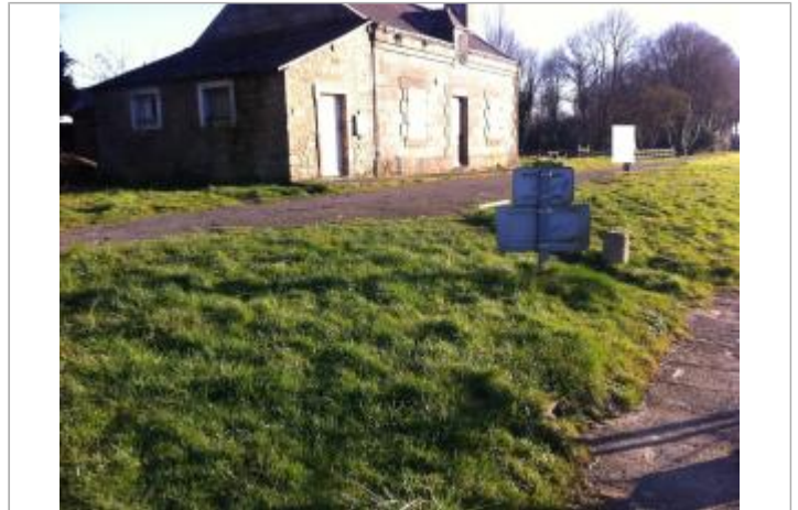
Maison éclusière en 2015
