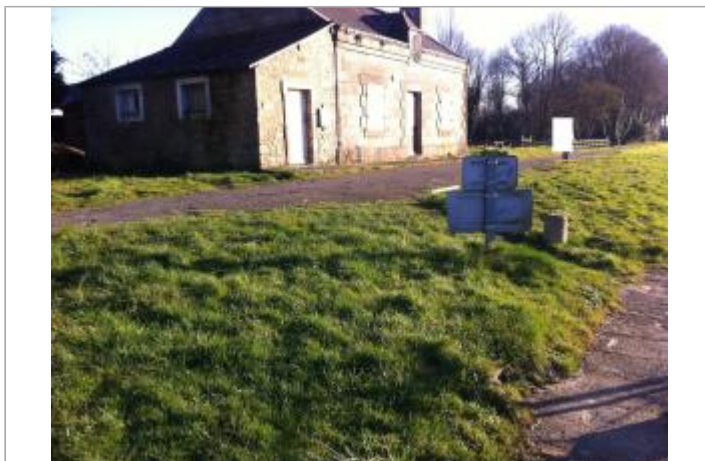
Maison éclusière en 2015
