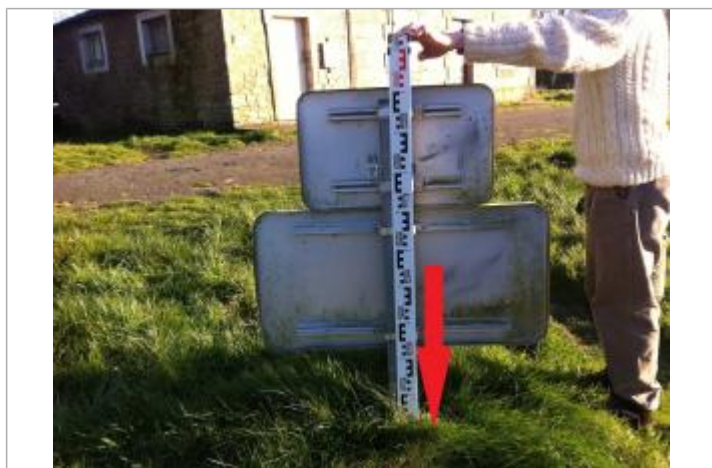
Sol au droit du poteau du panneau
