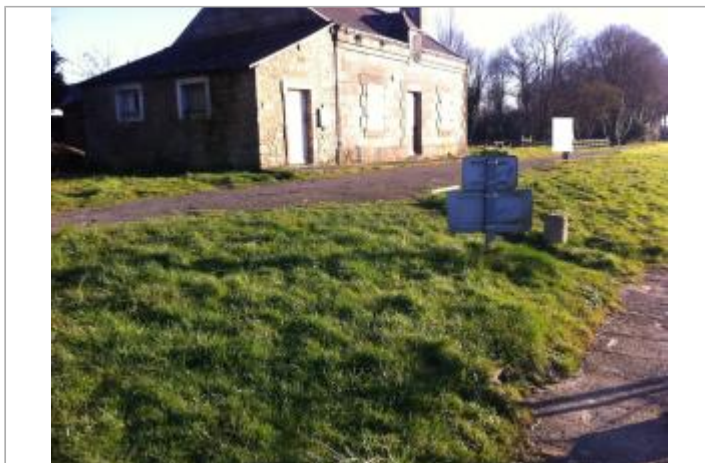
Maison éclusière en 2015
