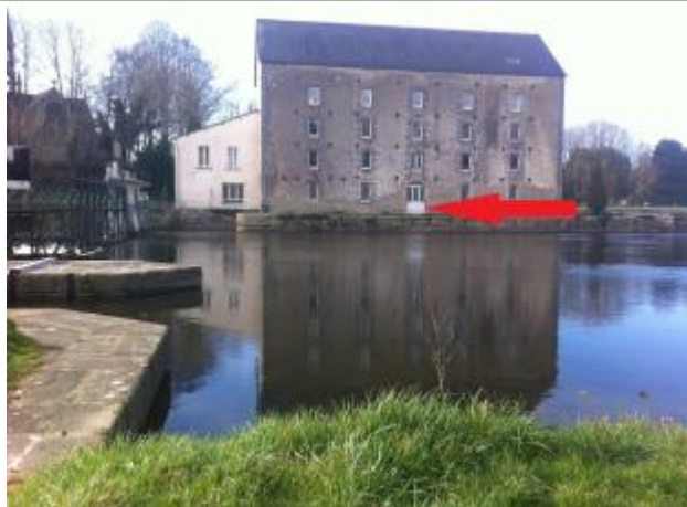
Façade du bâtiment
