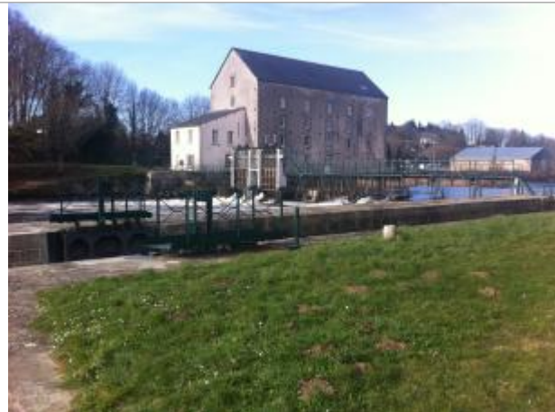
BATIMENT DU MOULIN
