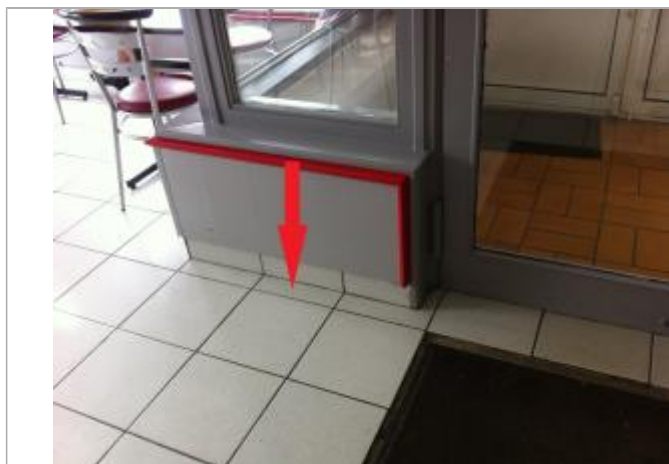
Plancher à l'intérieur du magasin
