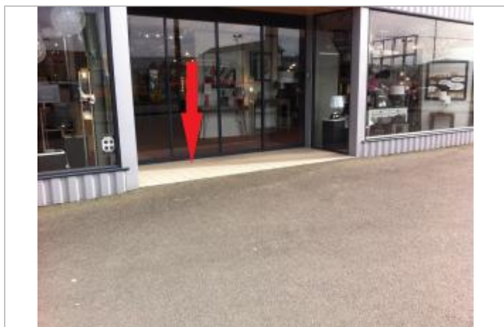
Seuil extérieur de la porte d'entrée du bâtiment
