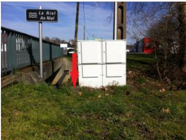
SOL SUPPORT BETON (AU DROIT DU COFFRET)
