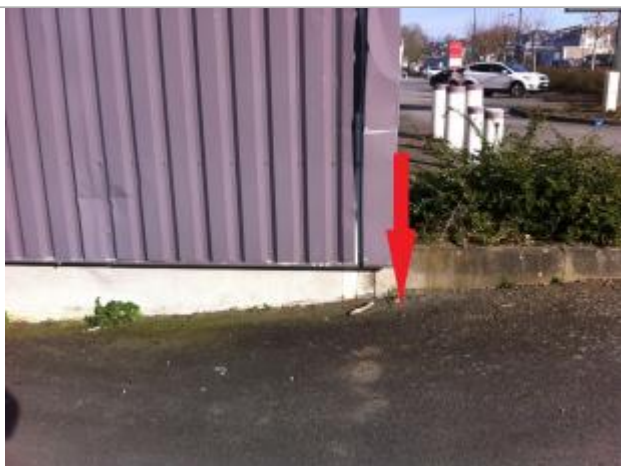
Sol (au droit / a l'angle du bâtiment)
