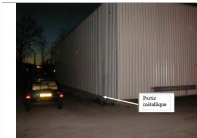
Partie métallique sur le côté du magasin Super Sport en 2001
