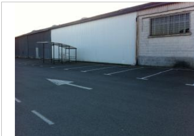
Façade du bâtiment en 2015
