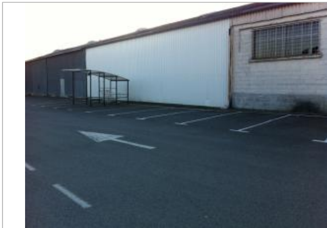
Façade du bâtiment en 2015
