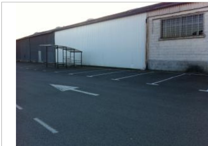
Façade du bâtiment en 2015
