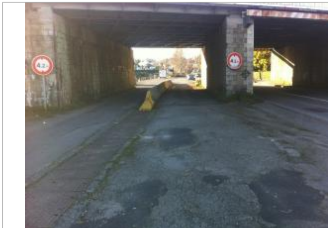
Vue d'ensemble du pont côté aval
