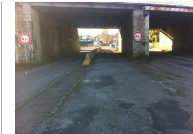
Vue d'ensemble du pont côté aval
