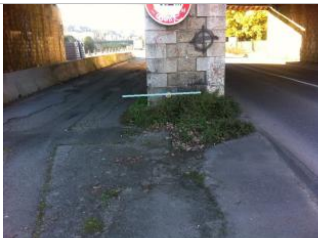
Vue d'ensemble du repère ( macaron NGF )
